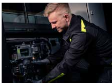
Dzień 2 montażu Montaż drzwi, założenie paneli szybu, podłączenia przewodów.
