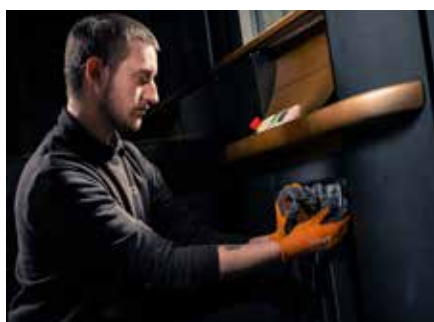
Dzień 1 montażu Montaż dolnej ramy, profili i platformy.
